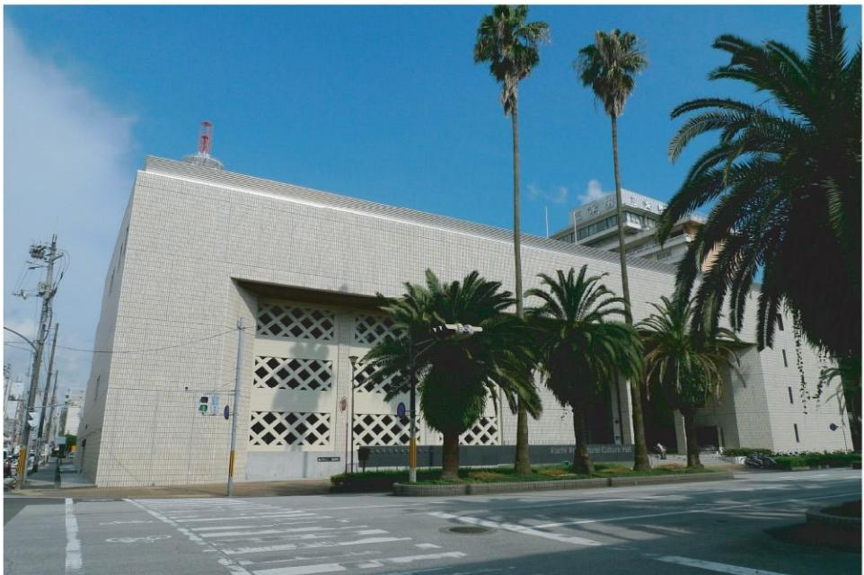
**評** 本建築は、芸術文化の創造と交流の場として開館して30年以上が経過したため大規模な改修がされ、耐震壁を増設するとともに鉄骨プレースにより耐震補強を行ったものである。
