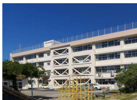
学校施設の耐震化事例
