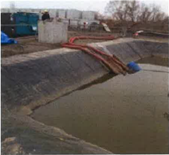
図 8-8 仮設水槽の例
