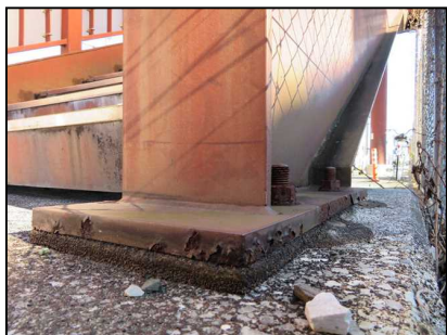
一宮323号線跨線橋（判定：Ⅰ）
