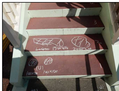
小津町1号歩道橋（判定：Ⅱ）
