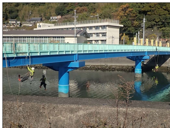
特殊高所技術による点検状況
