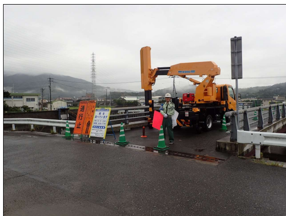
橋梁点検車による点検状況
