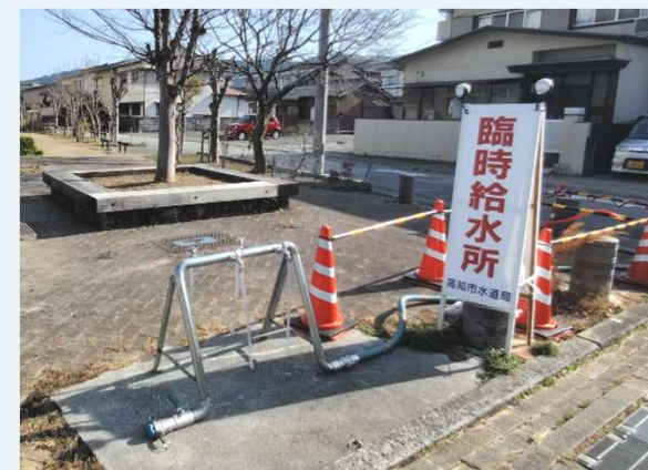
北竹島町に設置した応急給水栓
