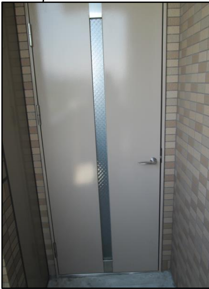
外階段から避難スペースへの入口
