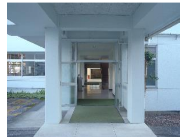
南舎北側入口
