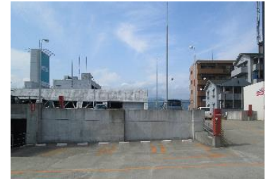
屋上スペース
