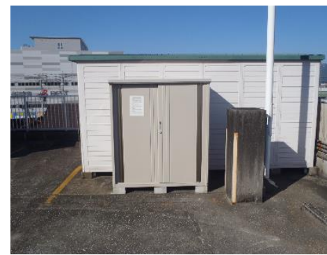
資機材保管庫
