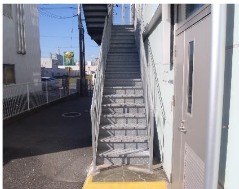
事務所棟外階段
