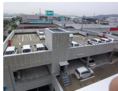
駐車場棟屋上
