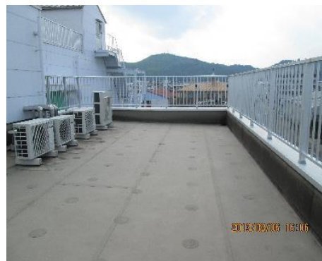
事務所棟屋上
