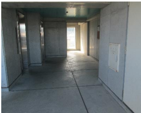
エレベーターホール
