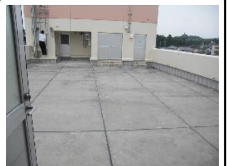
屋上避難スペース
