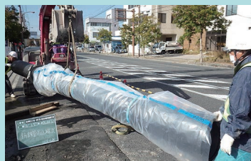
水道管の布設替工事(耐震化)
