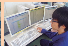
ポンプ稼働状況の監視
