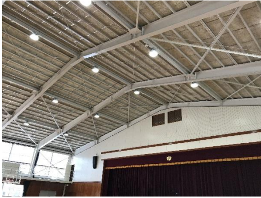
②体育館：照明などの落下物がないか
