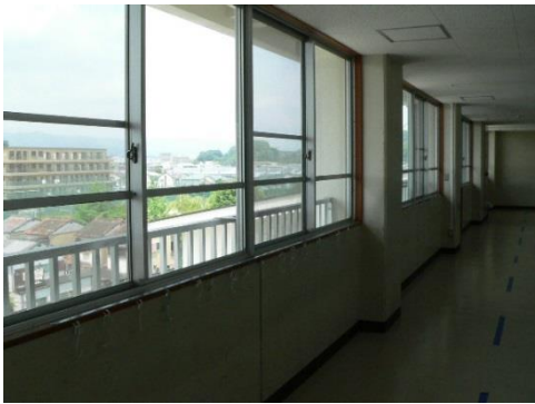
①各教室前廊下：ガラスの割れはないか、扉のゆがみがないか確認
