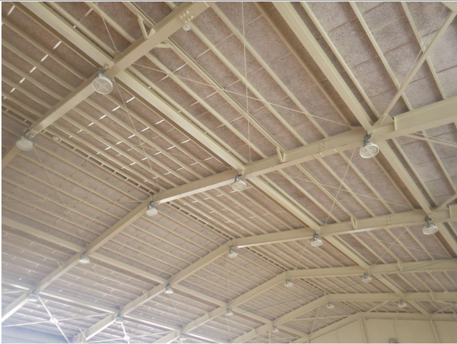
天井：照明などの落下物がないか確認
