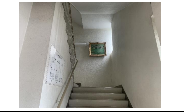
③階段：ひび割れていないか確認
