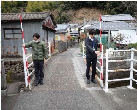
既存道路を活かして効率的に道路を確保
