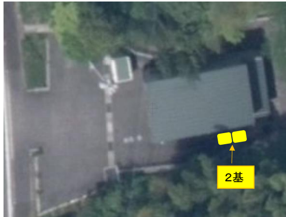
防災資機材庫の東側に2基設置
