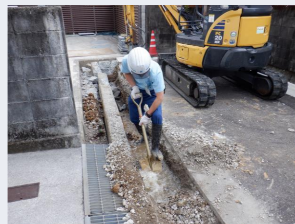
管路管理課 破損した水道管の修繕作業
