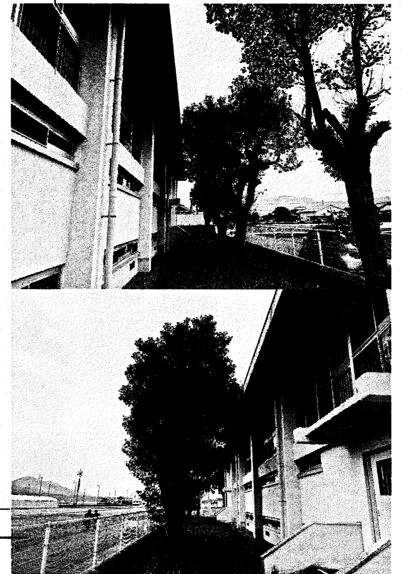
北面 樹木剪定 2箇所
