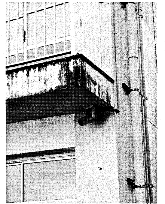
※防犯カメラは外部足場に移植し、足場解体後再取付け
