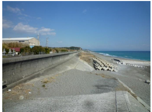
【写真2】 戸原地区海岸堤防
