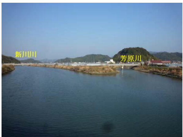
【写真8】 新川川中流護岸（西諸木）
