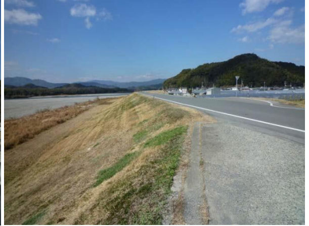
【写真5】 仁淀川上流護岸
