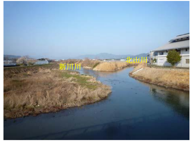
【写真7】 新川川上流護岸（西分）
