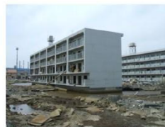
津波浸水後、地盤沈降により周辺が浸水した石巻市内の住宅
