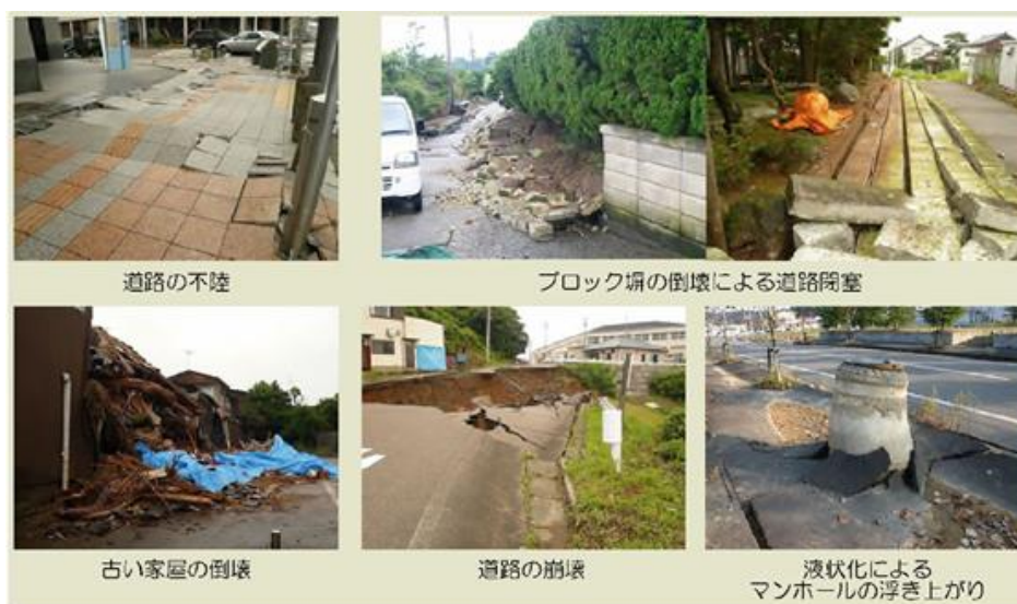
図7 揺れによって想定される被災状況
