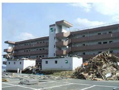
甚大な津波被害があった南三陸町で 町民の命を守った住宅
