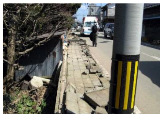
ブロック塀倒壊
