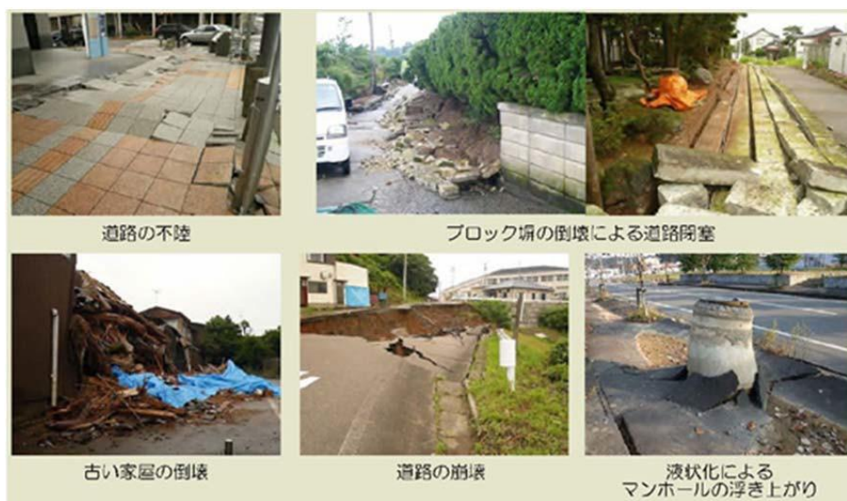
図8 揺れによって想定される被災状況
