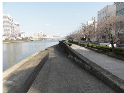
②潮江橋下流の状況
