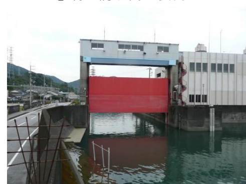
④孕橋より上流側の状況
