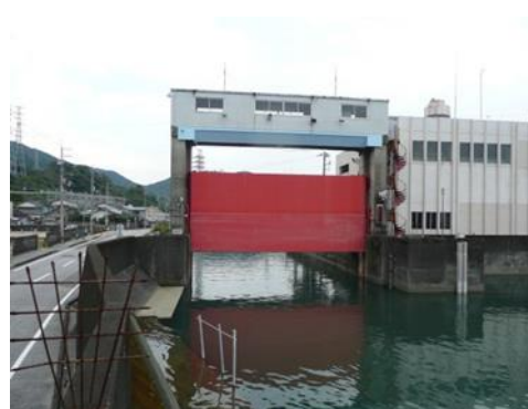
④孕橋より上流側の状況
