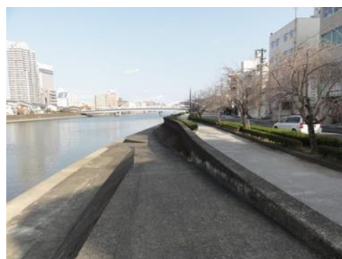
②潮江橋下流の状況
