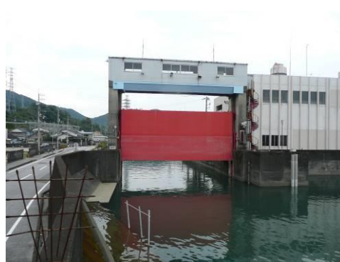
④孕橋より上流側の状況
