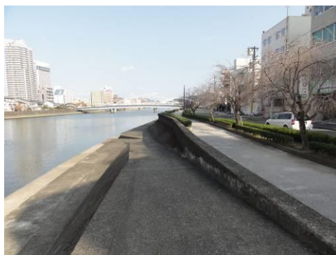
②潮江橋下流の状況
