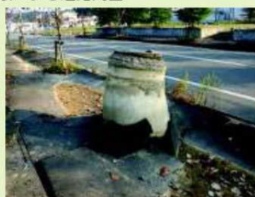
液状化によるマンホールの浮き上がり
