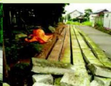
ブロック塀の倒壊による道路閉塞
