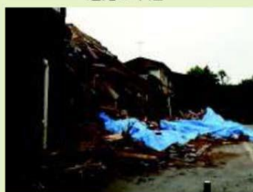
古い家屋の倒壊
