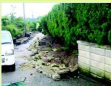
ブロック塀の倒壊による道路閉塞
