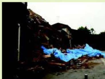
古い家屋の倒壊
