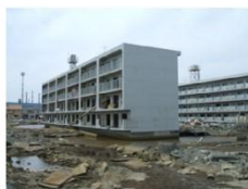
津波浸水後、地盤沈降により周辺が浸水した石巻市内の住宅
