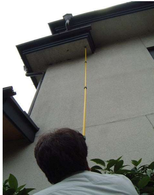
外壁の寸法調査
