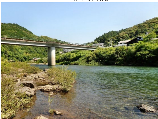
St. 17 (札場ノ下橋)
