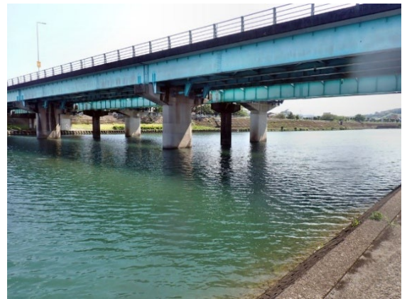
St. 6 (廓中堰湛水部上流)
