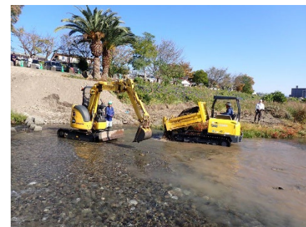
トリム堰付近での河床整備状況
