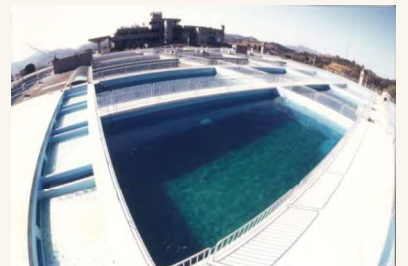
2系浄水施設完成
