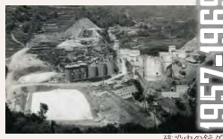
建設中の鏡ダム
