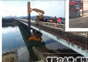
管路の点検・維持管理
