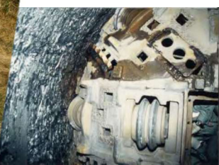
岩盤掘削状況
