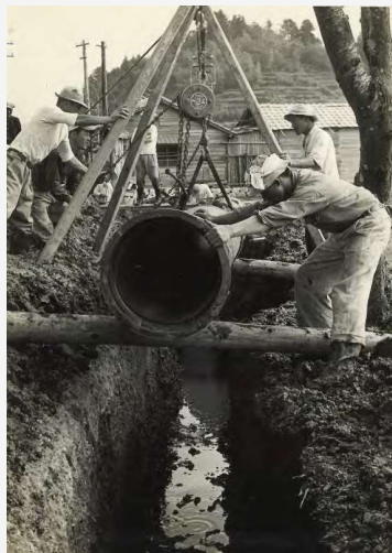
配水管布設(福井町)
