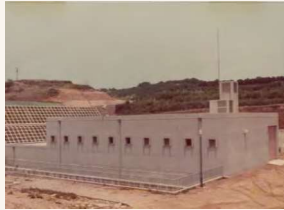
中継ポンプ所
