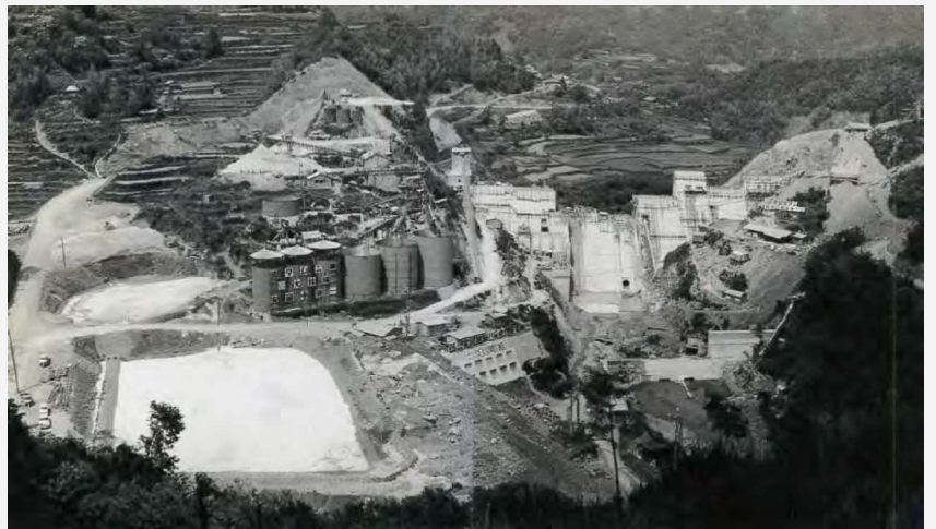
鏡ダム建設工事
