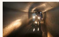
導水路内点検状況
