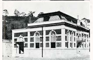
上 集水管理設工事(鏡川郭中堰上流) 中 取水所(宝橋付近) 下 送水ポンプ室
