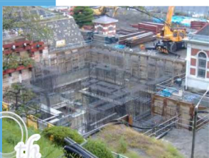
地下浄水池配筋状況
