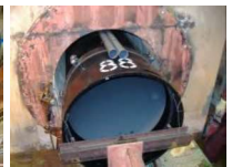
内挿管設置状況
