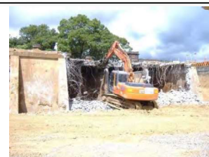
旧1号配水池取壊し
