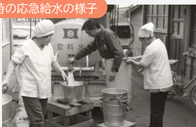
断水時の応急給水の様子
