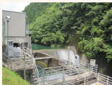
地蔵寺川取水堰
