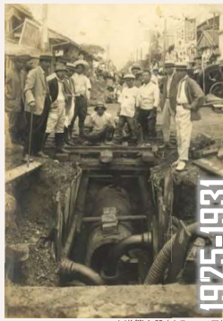
水道管布設(本町一丁目)
