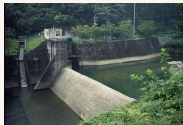
瀬戸川取水堰
