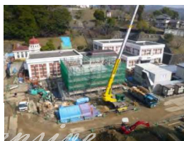
後塩素混和池施工
