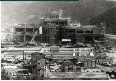
管理本館建設
