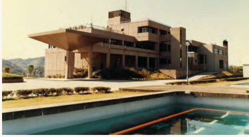
針木浄水場完成(昭和54年3月)
