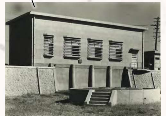
拡張に合わせて移転した取水所
