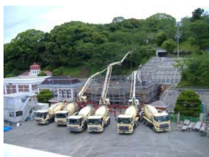
管理棟コンクリート打設
