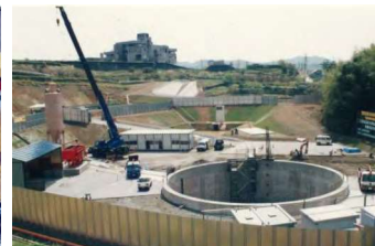
揚水所建設状況
