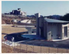
針水浄水場・揚水所
