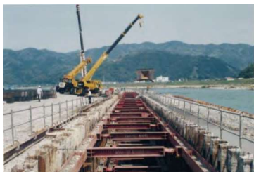
集水管埋設工事
