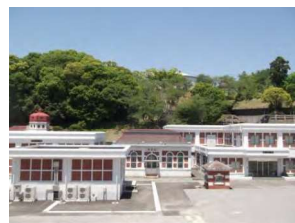
新浄水施設完成
