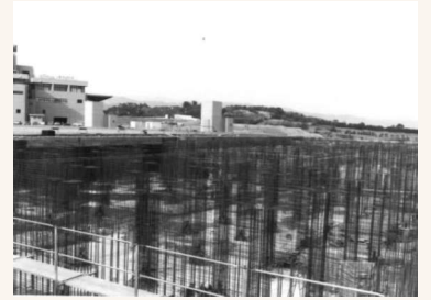
総合配水池配筋状況
