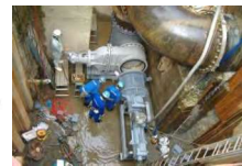
不断水割T字管設置状況
