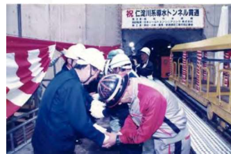
仁淀川系導水トンネル貫通
