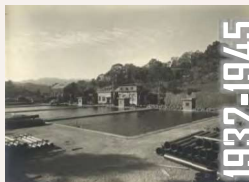
旭浄水場全景
