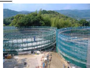
配水池配筋状況
