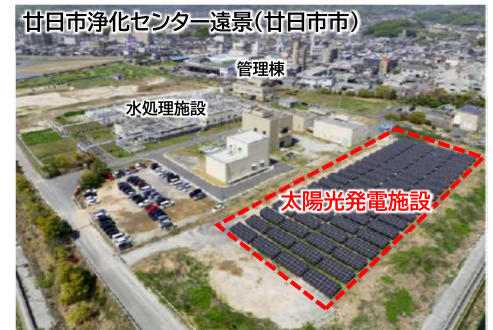
下水処理場への太陽光発電施設の設置状況 提供：廿日市市
