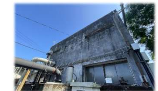
南地ポンプ場 (現況)
