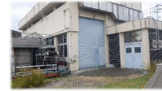
江ノ口ポンプ場 (現況)
