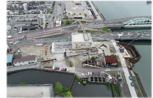
下知ポンプ場の建替え状況 (R7現在)
