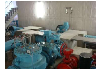
一宮送水所内部
