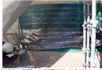
北部高地区配水池耐震補強(炭素繊維シート)
