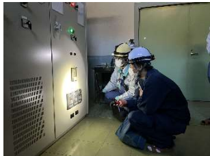
施設設備の点検
