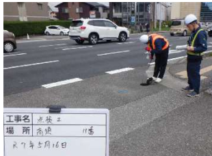
管路路面点検
