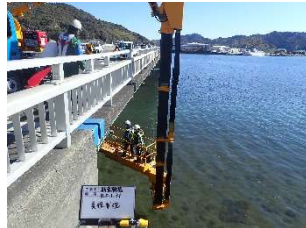
橋梁添架管点検
