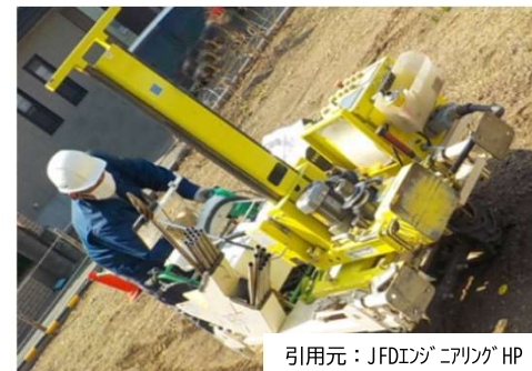
○空洞調査 (簡易貫入試験)
