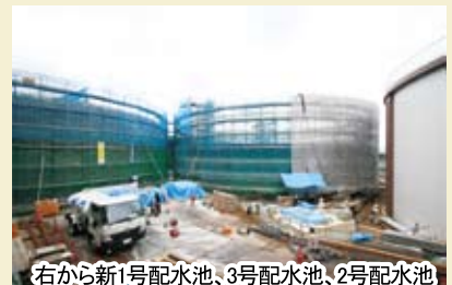
右から新1号配水池、3号配水池、2号配水池
