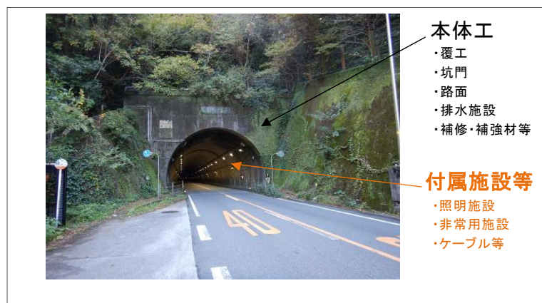
図-2 トンネル構造
