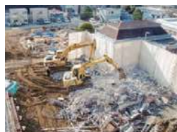
旧第3ポンプ室解体
