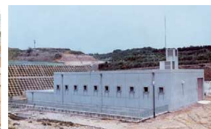
中継ポンプ所
