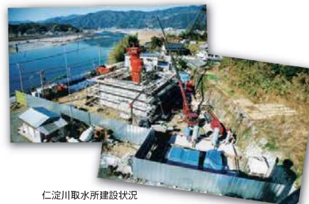
仁淀川取水所建設状況
