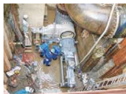
不断水割T字管設置
