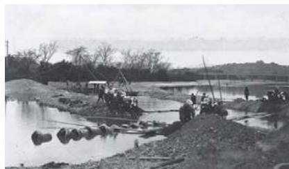
集水管埋設工事（大正13年1月）
