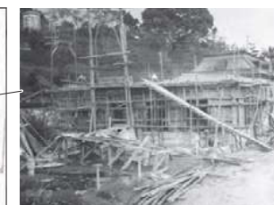
送水ポンプ場増設工事
