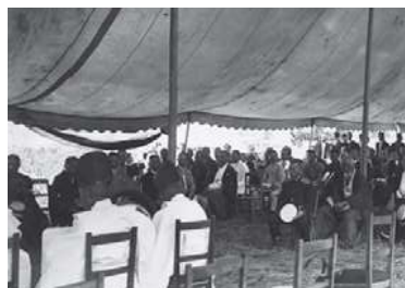
上水道施設起工式（大正12年7月6日）
