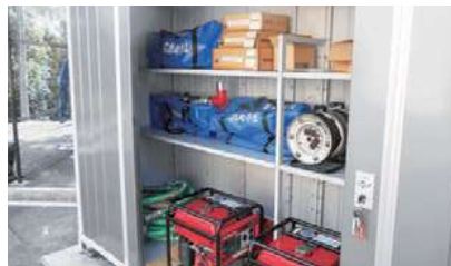
応急給水用資機材倉庫
