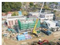
後塩素混和池施工
