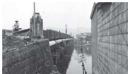
雄喉橋橋添架工事
