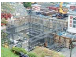
地下浄水池配筋状況
