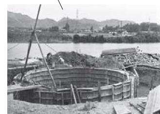
本宮町取水井築造工事
