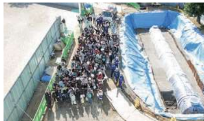
耐震性非常用貯水槽設置(一宮小学校)
