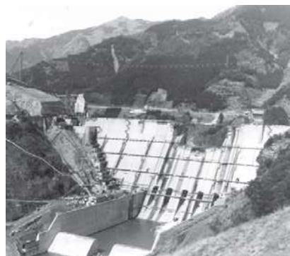
建設が進む大渡ダム
