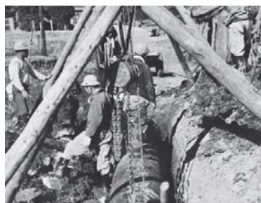
導水管埋設工事
