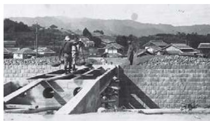
取水所における練積石垣及び鉄管橋の築造
