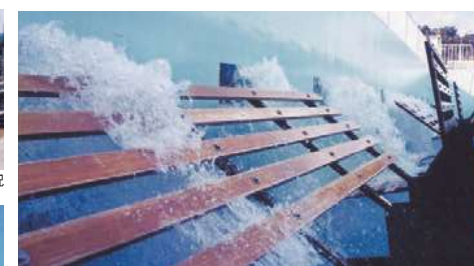
試運転が始まったフロック形成池
