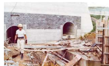
導水トンネル（仁淀川・高知分水）
