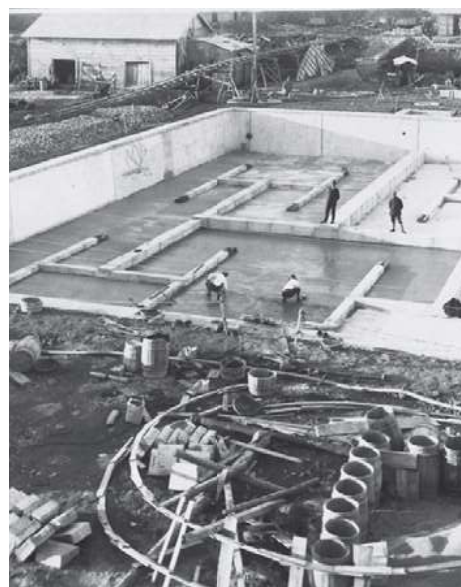
ろ過池排水渠工事
