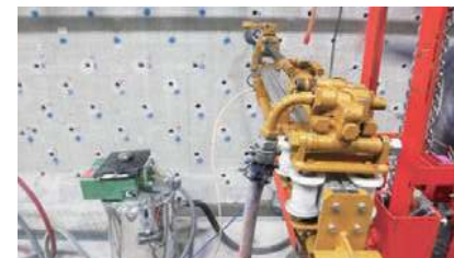
せん断補強筋による耐震補強(針木浄水場)
