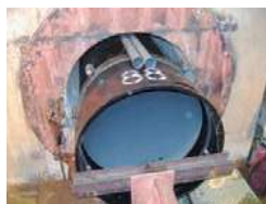
内挿管設置状況
