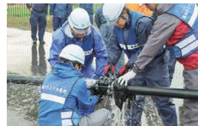
応急復旧訓練
