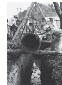
配水本管布設工事
