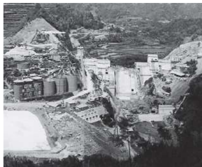
鏡ダム建設工事
