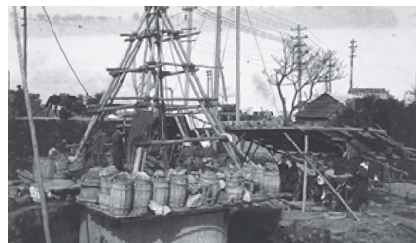
取水井沈下作業（大正13年4月）
