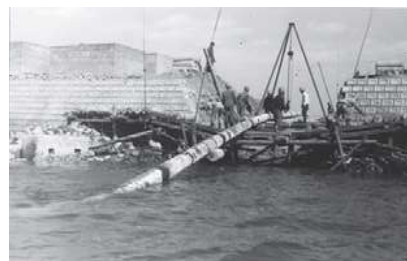
海底配水管布設状況
