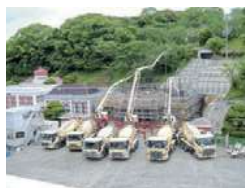
管理棟コンクリート打設
