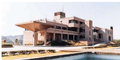
針木浄水場完成（昭和54年3月）
