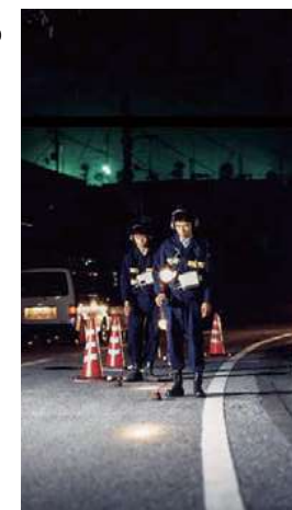
夜間の漏水調査の様子
