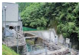
地蔵寺川取水堰
