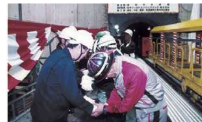
仁淀川系導水トンネル貫通
