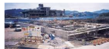
ろ過池建設状況
