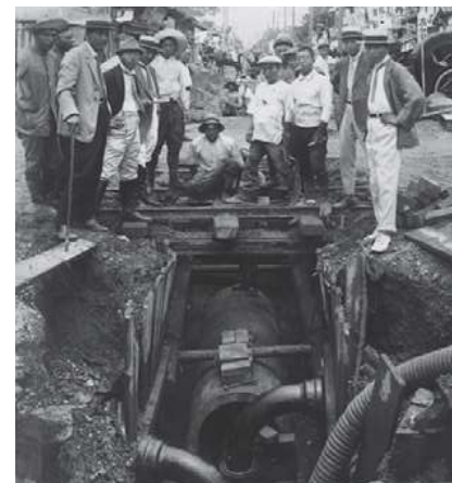
電車軌道下への鉄管伏越し工事
