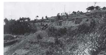
配水池へのインクライン鉄管巻上作業
