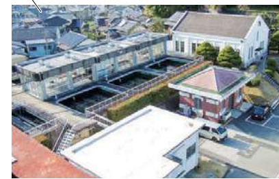
急速ろ過池(平成17年頃)
