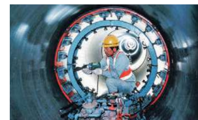
内部継手施工
