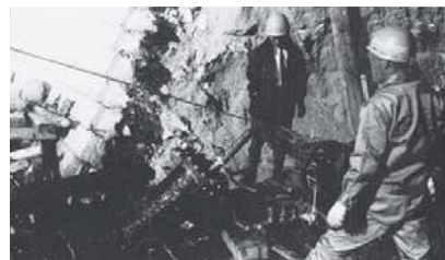
海底配水管水圧テスト
