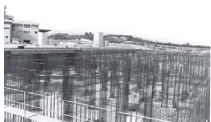
浄水処理施設配筋状況
