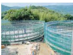
配水池配筋状況
