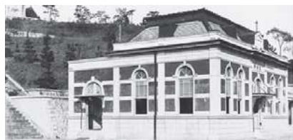
送水ポンプ室
