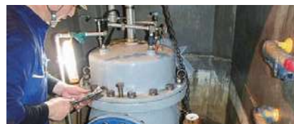
減圧弁のメンテナンス
