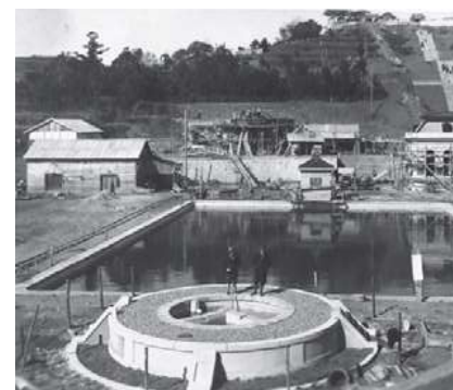
建設進む浄水場（大正13年12月）
