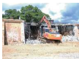
旧1号配水池取壊し
