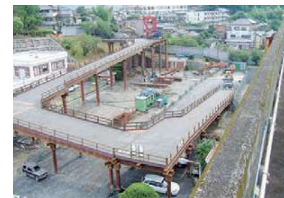
配水池への仮設道路
