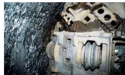
岩盤掘削状況
