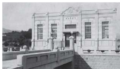
取水所（螢橋付近）
