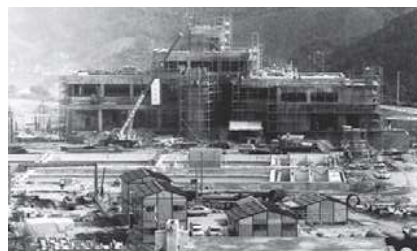
管理本館建設
