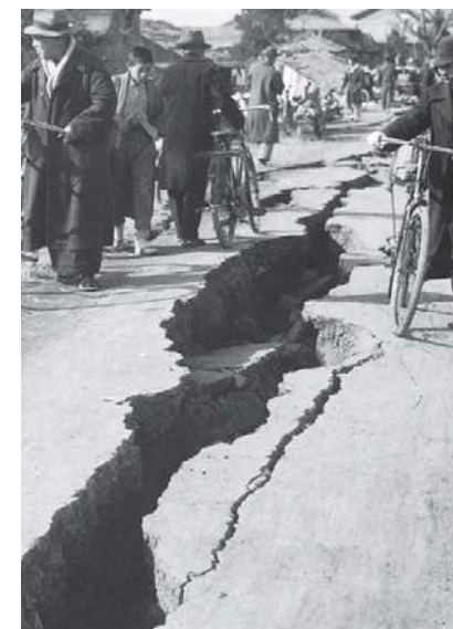
桜井町の被災状況
