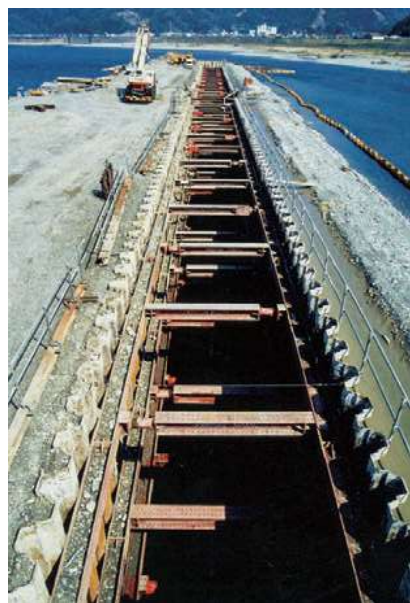
集水管埋設工事
