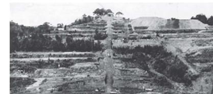
御殿山に浄水場建設を着手 （大正13年6月）
