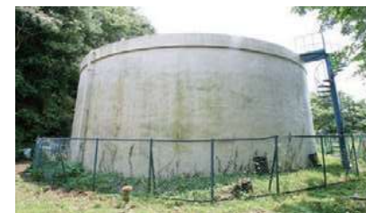
春野町弘岡上配水池
