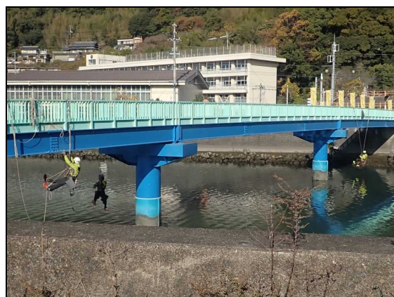
特殊高所技術による点検状況
