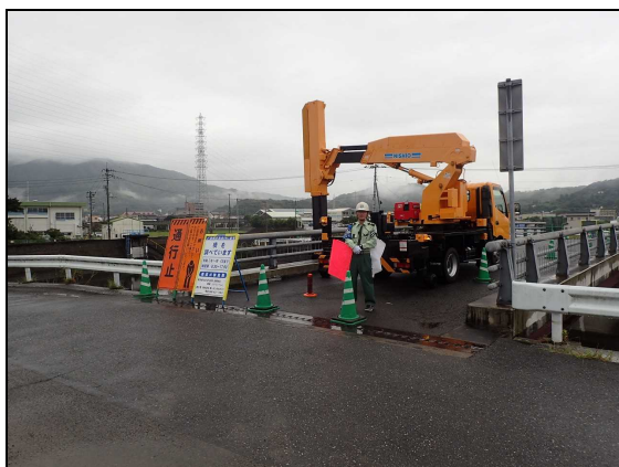
橋梁点検車による点検状況
