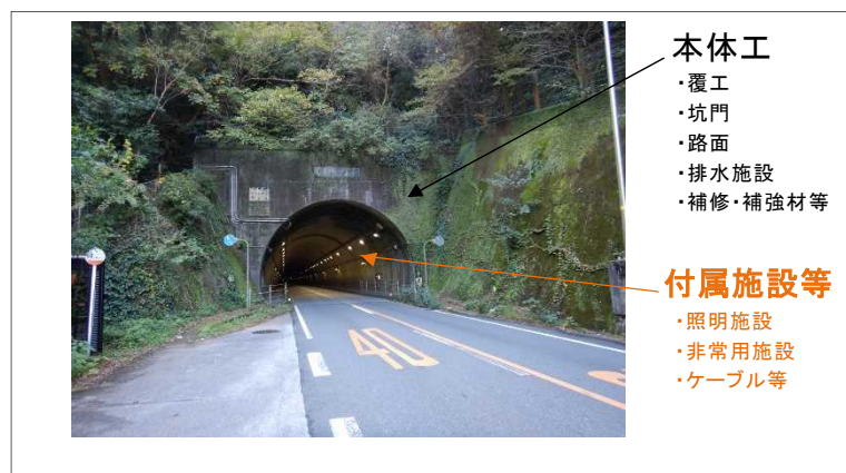
図-2 トンネル構造
