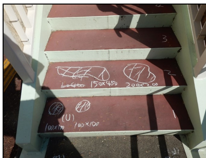
小津町 1 号歩道橋（判定：Ⅱ）
