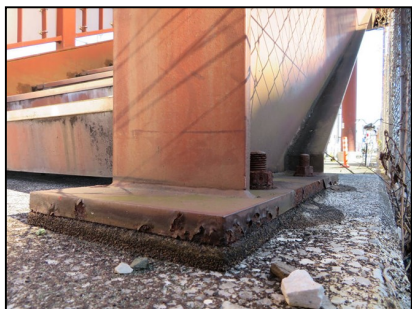
一宮 323 号線跨線橋（判定：Ⅰ）
