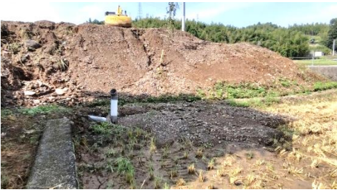
水田に流れ込んだ盛土の土砂
