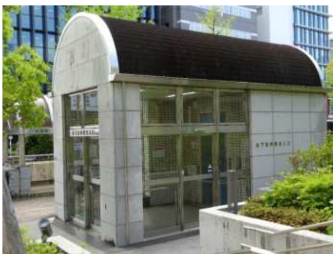
7 エレベータ（北西）
