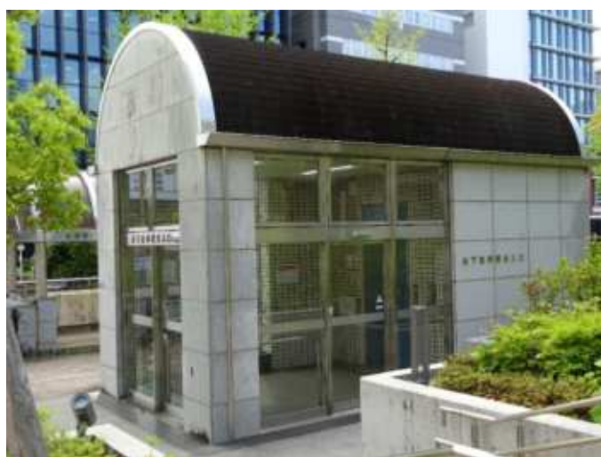
7 エレベータ（北西）
