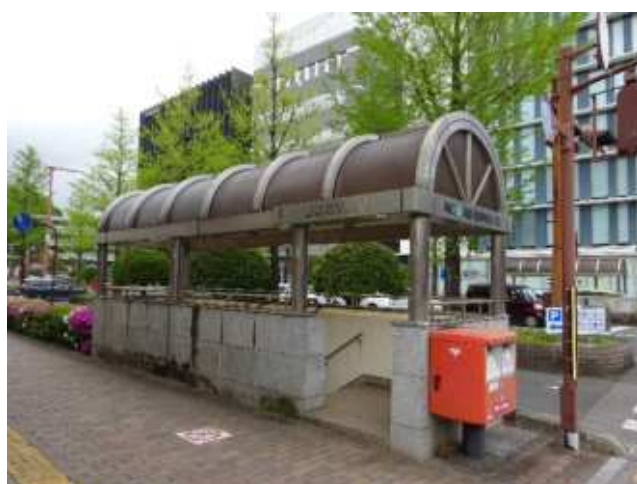
6 利用者出入口（南西：D階段）
