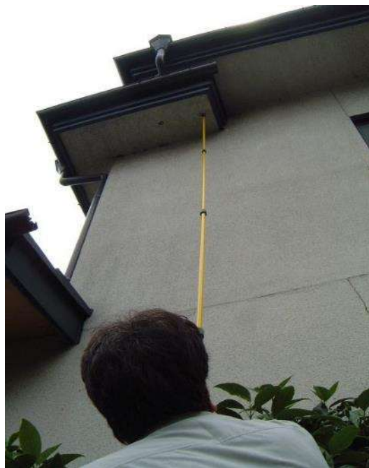
外壁の寸法調査
