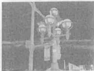
②一文橋欄干の街路灯修理
